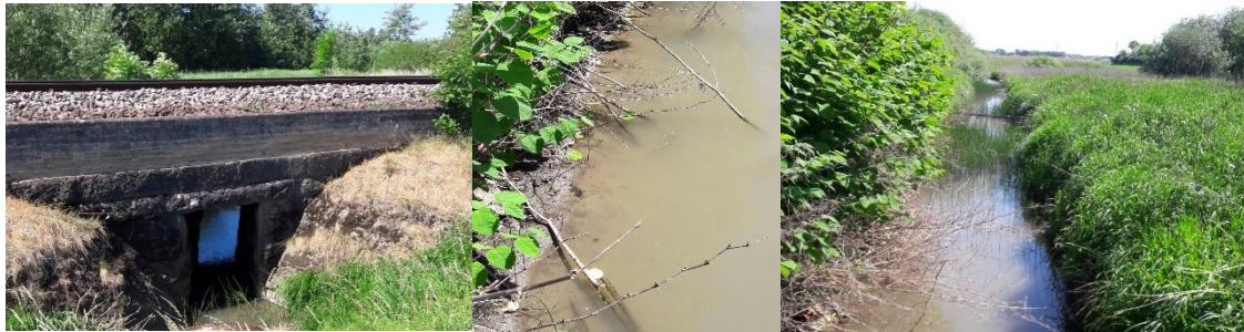
Bild 1. Provpunkt 1. Flöjen två diken. Det ena diket gick under järnvägen, det andra längs med järnvägen. Mittenbilden visar vattnets färg. (Foto: Pähr Hellström)
