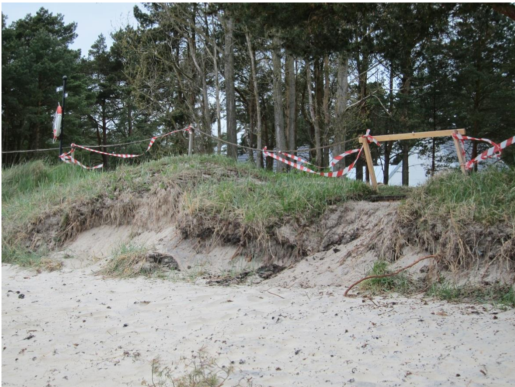
Figur 2-3 Erosion av dyner vid Östra Sand, Åhus. Foto: SGU
