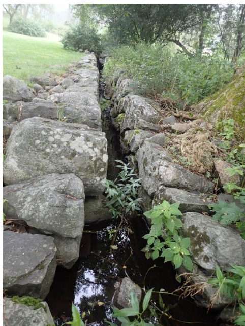
Figur 50. Den nedersta delen av vattendraget som avvattnar Kottlasjön utgörs av en murad ränna.
